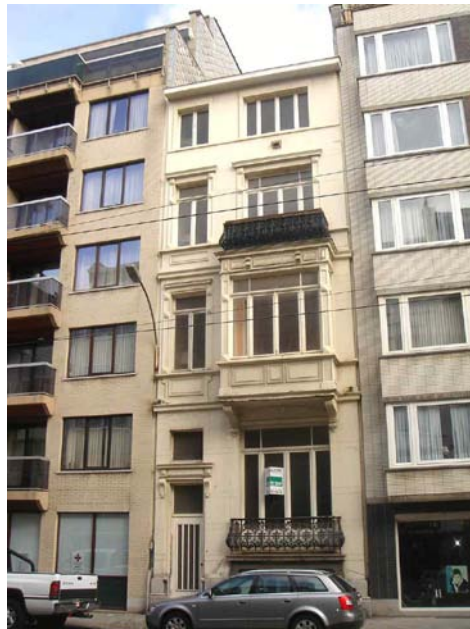
Belle Epoquepand in de Torhoute-steenweg 58.
